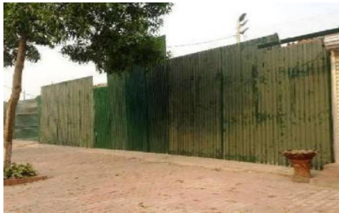
Hình 4.2. Biện pháp che chắn công trình
